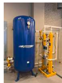
Адсорбционный осушитель воздуха
